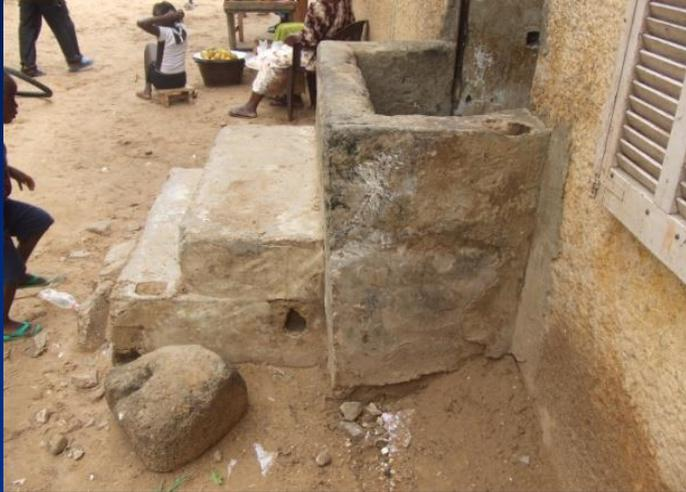
Elévation de briques pour résister aux inondations
