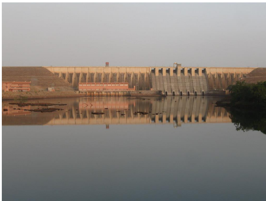
Figure 2 : Barrage de Manantali. Source : Jake Asher
