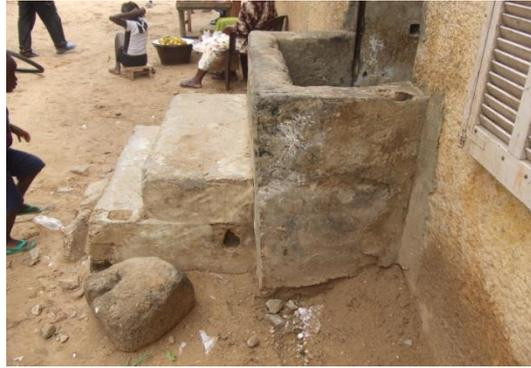
Photo 4 : Elévation de briques pour résister aux inondations
