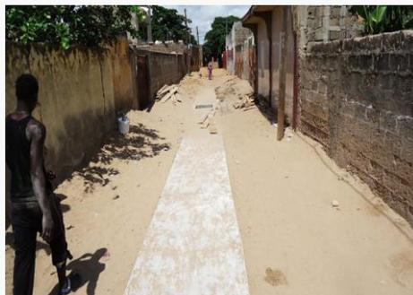
Photo 4 : Conduite secondaire de drainage construite Al Pulaar à Yeumbeul Nord (IAGU, 2015)
